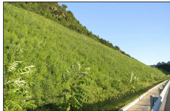
边坡植草防护实景图
