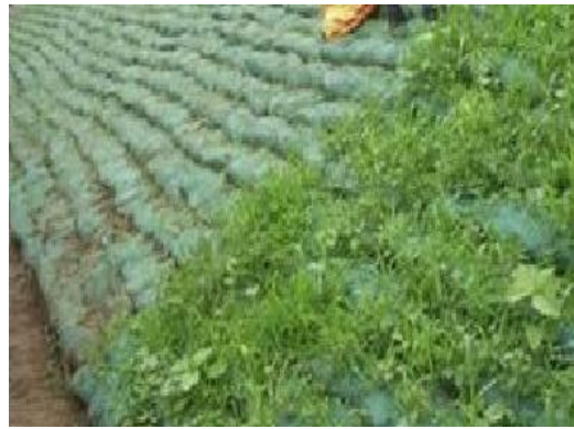
图 5.2-5 三维排水柔性生态护坡效果图
