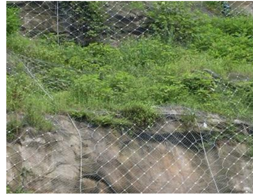
图 5.2-6 主动防护网效果图
