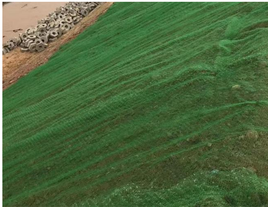
图 5.2-21 三维水土保持毯护坡
