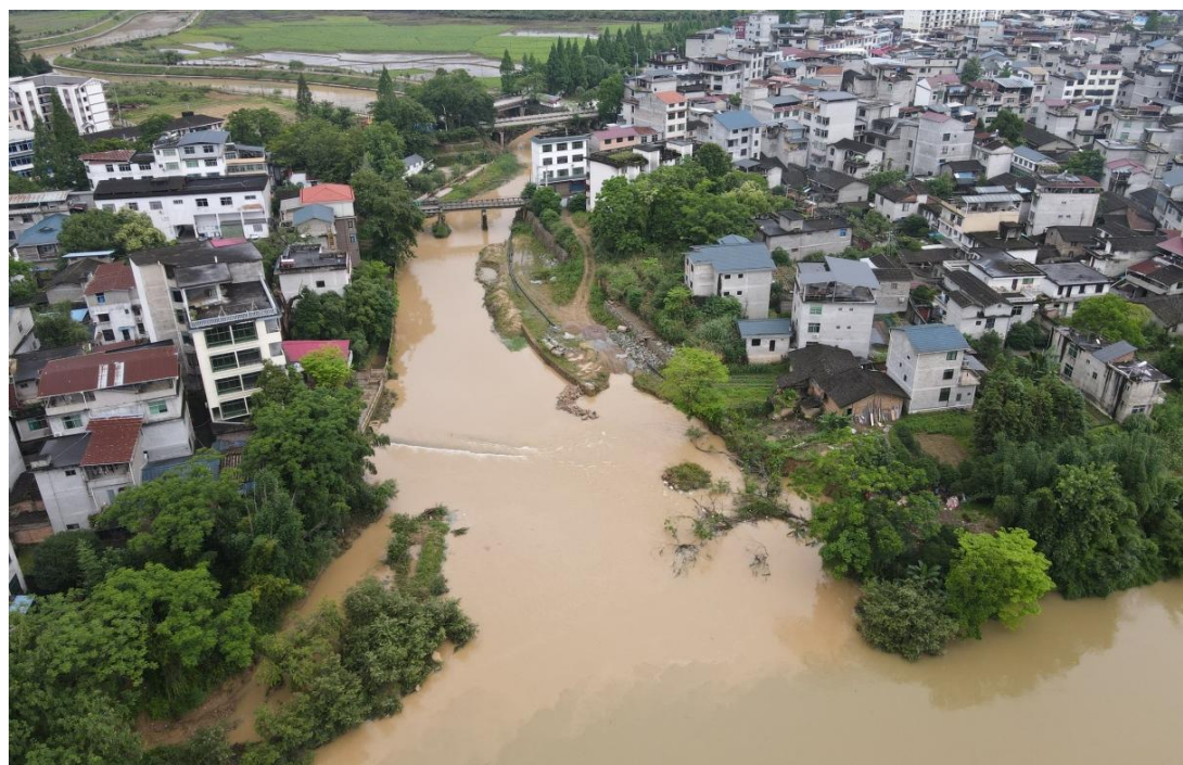
图 5.2-15 现状坍塌护岸
