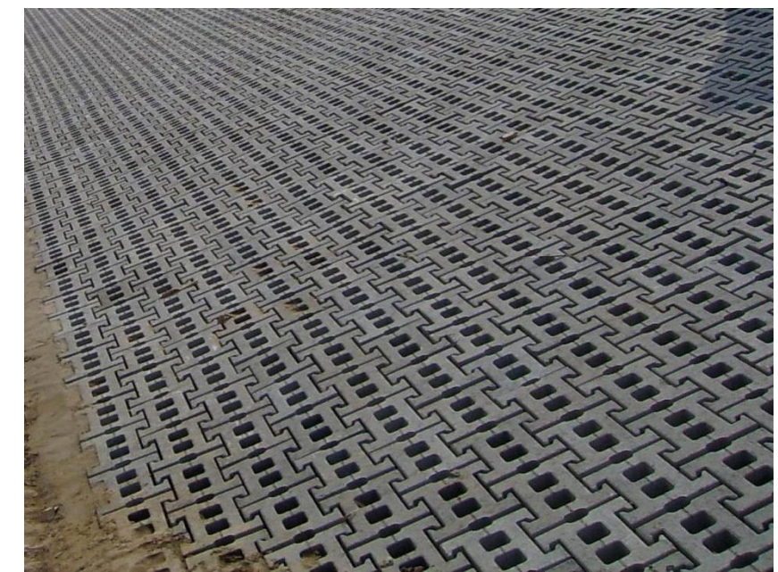
图 5.2-18 连锁型预制砼块护坡
