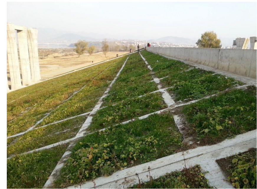
图 5.2-17 生物基质混凝土护坡
