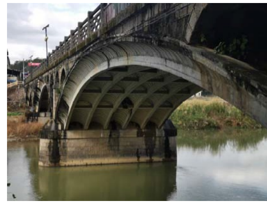
图2 主拱圈渗水
