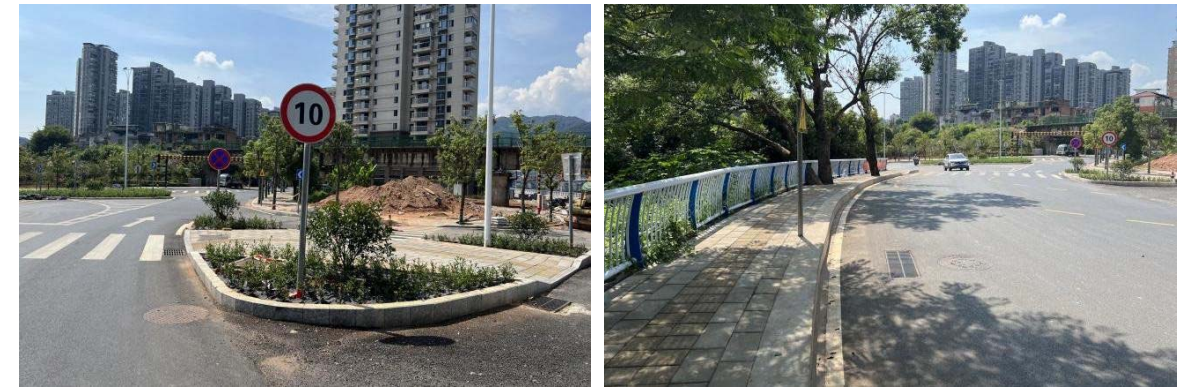
图 2-6 现状城西大桥与中山西路交叉口
