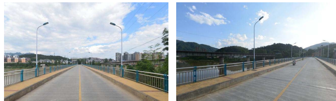
图 2-4 现状城西大桥
