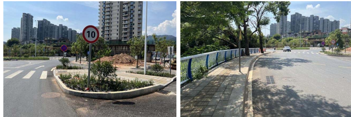
图 2-6 现状城西大桥与中山西路交叉口
