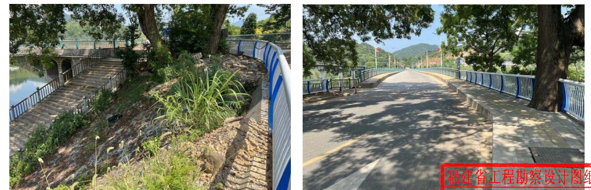
图 2-5 现状城西大桥终点处
