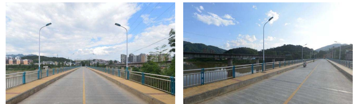
图 2-4 现状城西大桥
