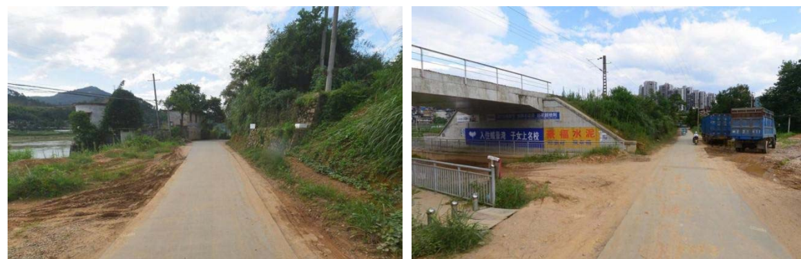
图 2-8 现状华阳路及西岗小区通道
