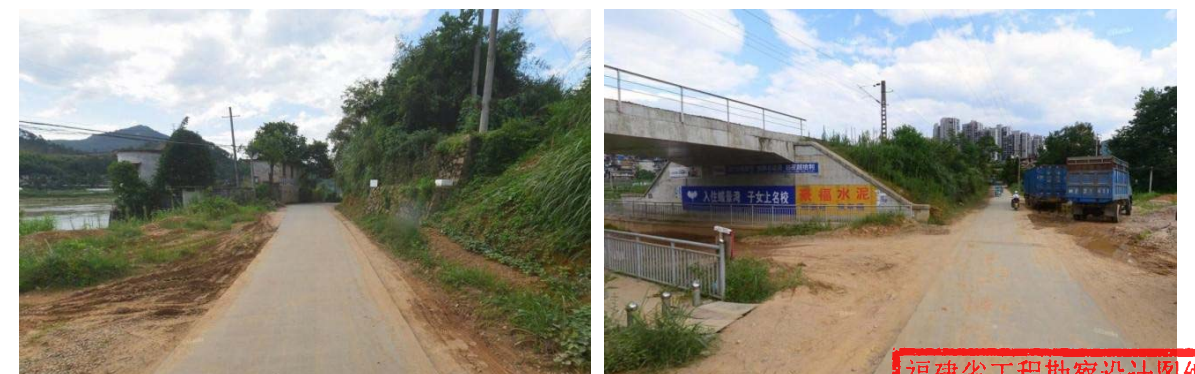
图 2-8 现状华阳路及西岗小区通道
